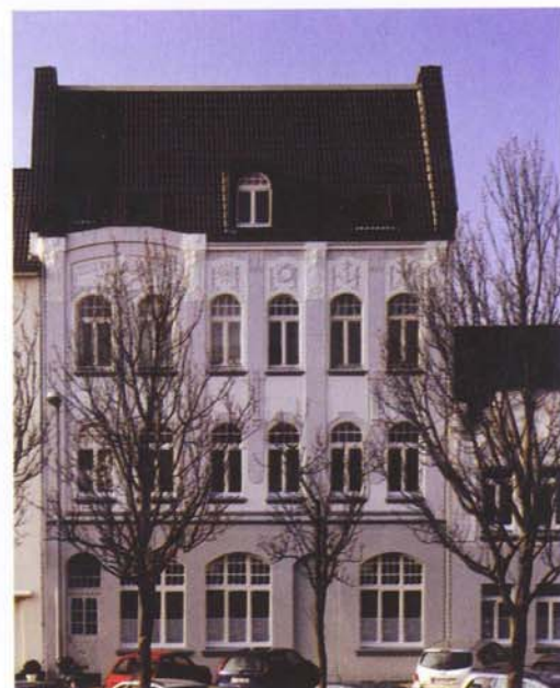
9 Anerkennung: Das Farbkonzept für das Mülheimer Wohnhaus besticht durch die Tiefenwirkung der Bildelemente. (Foto: SWB Service-, Wohnungsvermietungs- und -baugesellschaft, Mülheim)
