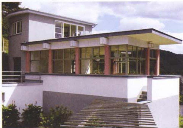
9 Anerkennung: Der originalgetreue Rückbau eines Café-Pavillons in Probstzella zeigt sich wieder in der Farbgebung, die einst der Architekten und Bauhausschüler Alfred Arndt vorgegeben hatte.
