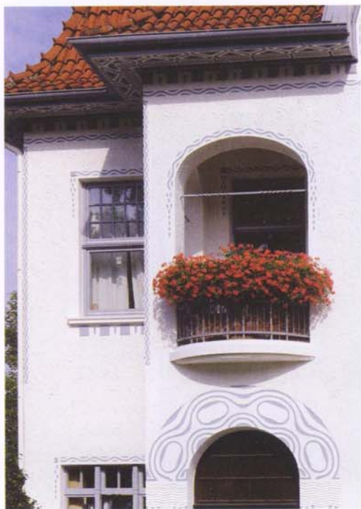
8 Anerkennung: Feinfühlig neu gefasste Fassadendekoration einer Jugendstilfassade in Oldenburg.
