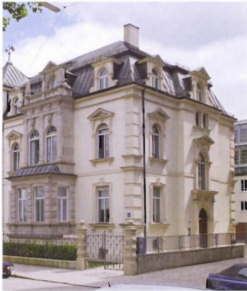
7 Die Fassade des prämierten Münchener Stadthauses wurde detailgerecht saniert und in zurückhaltenden Beigetönen neu gestaltet. 2. Preis, Kategorie Historische Gebäude und Stilfassaden.
