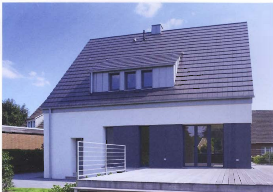
Früher eine Klinkerfassade, jetzt mit einer modernen Wärmedämmung ausgestattet: Einen Sonderpreis gab es für dieses Wohnhaus in Bocholt.
