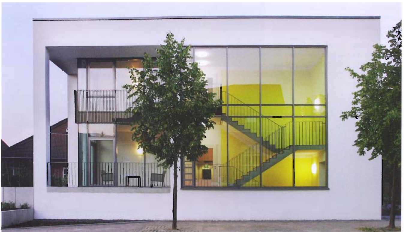
Eine Anerkennung bekam der Erweiterungsbau eines Altenwohnheims in Neuss. Das verglaste Treppenhaus reflektiert die farbigen Akzente der Innenwand je nach Lichteinfall unterschiedlich.
