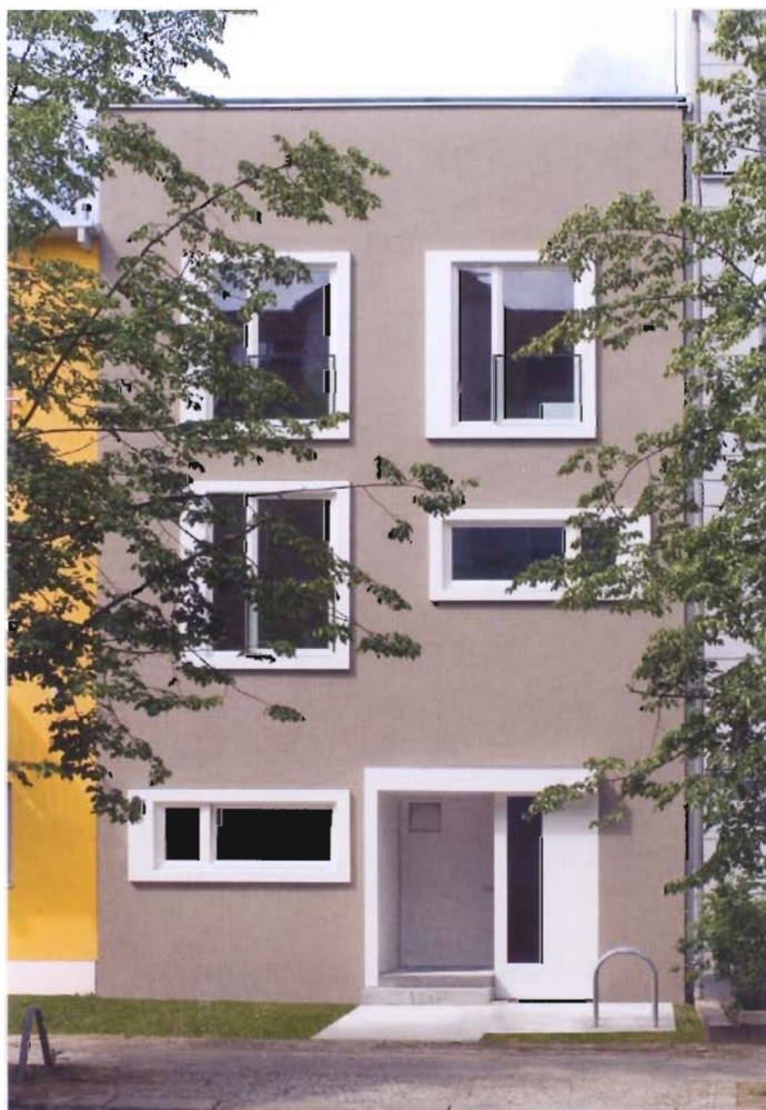
Ungewöhnlich elegant setzt sich dieses neue Berliner Stadthaus mit seiner Fassadengestaltung im gewachsenen Umfeld durch. Die Jury vergab dafür den ersten Preis.
