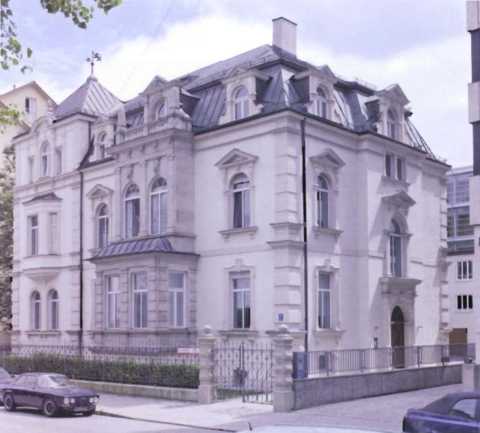
2. Preis Historische Gebäude und Stilfassaden: Die Fassade dieses Münchener Stadthauses wurde detailgerecht saniert und in zurückhaltenden Beigetönen neu gestaltet.
