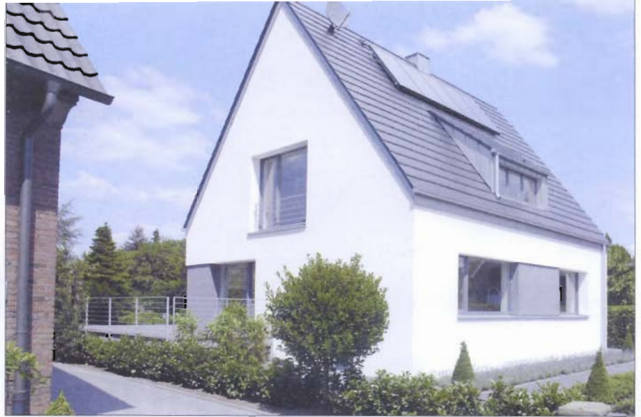
Sonderpreis: Energetisch und optisch wurde das 50er-Jahre-Einfamilienhaus in Bocholt auf den aktuellsten Stand gebracht. (Fotos: Brillux)
