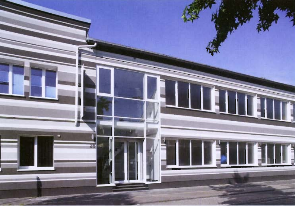
1 Kategorie Industrie- und Gewerbebauten, 1. Preis: Ein bemerkenswerter neuer Auftritt gelingt einem Metall verarbeitenden Unternehmen in einem Wuppertaler Gewerbegebiet mit einer klug durchkomponierten Streifenoptik.
