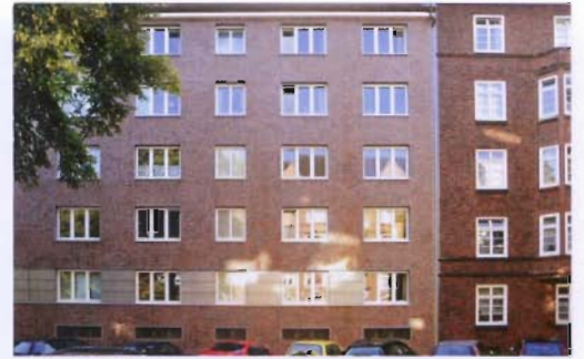
10 Kategorie Wohn- und Geschäftshäuser, Förderpreis: Die energetische Sanierung dieses Klinkerbaus in Hamburg überzeugt – auch durch den besonders behutsamen Umgang mit der Bestandsgebäudehülle.
