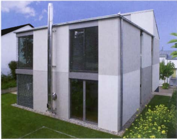
5 Kategorie Wohn- und Geschäftshäuser, 2. Preis: Das neu erbaute Wohnhaus in Saarbrücken spielt anspruchsvoll mit klaren Formen und betonender Fassadenrasterung in Grautönen.
