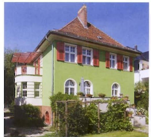
4 Kategorie Historische Gebäude und Stilfassaden, 2. Preis: Das neue farbige Kleid der Walmdach-Villa in Frankfurt (Oder) aus den 1930er-Jahren steht der historischen Architektur gut zu Gesicht.
