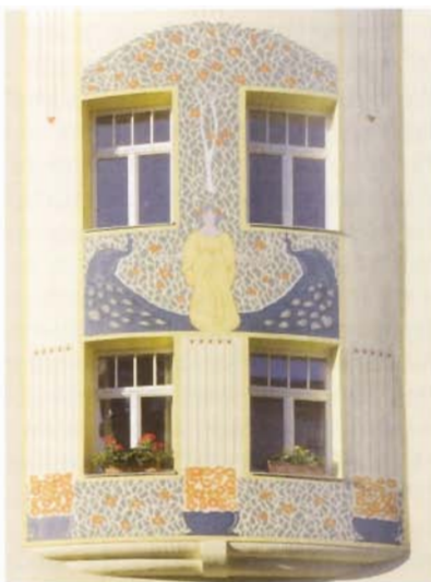
7 Kategorie Historische Gebäude und Stiffassaden, 3. Preis: Eine aufwendige Rekonstruktion des ursprünglichen, gemalten (und in den 1960er-Jahren übermalten) zeittypischen Fassadendekors gab dem Stilgebäude in Nürnberg seine Identität zurück.
